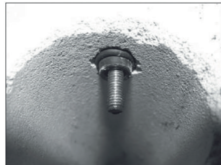
Mise en oeuvre dans maçonnerie creuse
