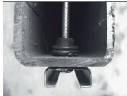
Mise en oeuvre dans tubes métalliques
